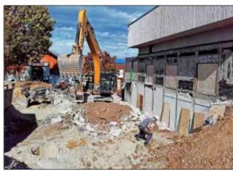
Das bisherige Foyer der Turn- und Festhalle wird abgerissen. Jetzt folgt der Neubau für ein größeres Foyer. Foto: Gemeinde/Bruno Müller
